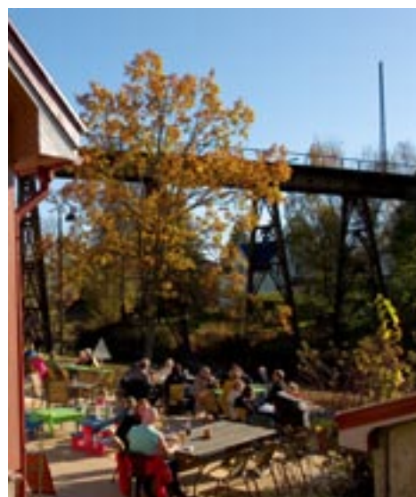
Hølen viadukt sett fra bokkaféen Karl Johan.
