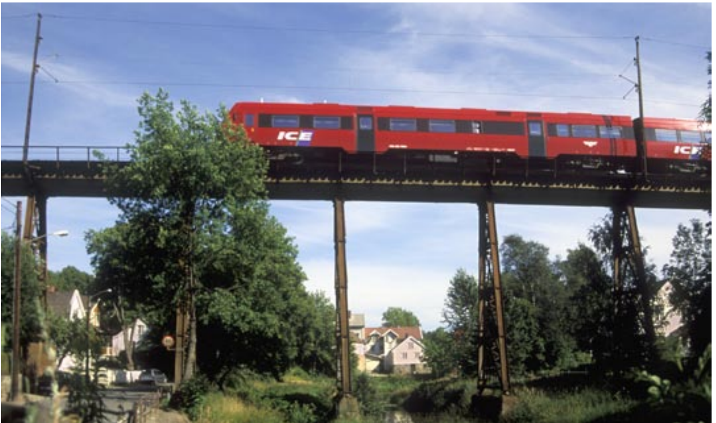
70-sett på Hølenbrua 24. juli 1994.
